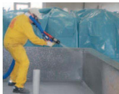
Membranele PU bicomponente lichide se aplică de obicei mecanic prin intermediul echipamentului de pulverizare
