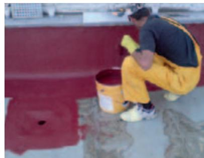
Membranele PU monocomponente se aplică în principal cu rolă și pensula (pensula este folosită întotdeauna pentru realizarea detaliilor).
