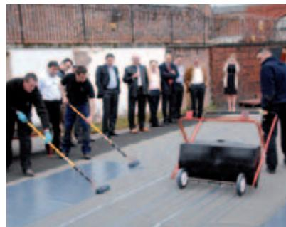
Pentru a accelera aplicarea membranelor PU monocomponente pe suprafețele mari s-a dezvoltat un instrument special – Aplicatorul **Sikalastic®**. Prin folosirea acestui echipament inovativ Sika, constructorii de acoperiș pot accelera procesul de aplicare și reduce costurile pentru zonele mari deschise.
