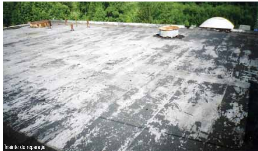
Înainte de reparație
