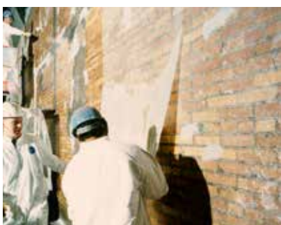
REABILITARE SEISMICĂ/REPARAREA DAUNELOR PRODUSE DE CUTREMURE
