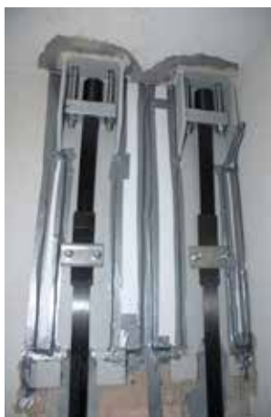
Ancorarea sistemului Sika CarboStress
