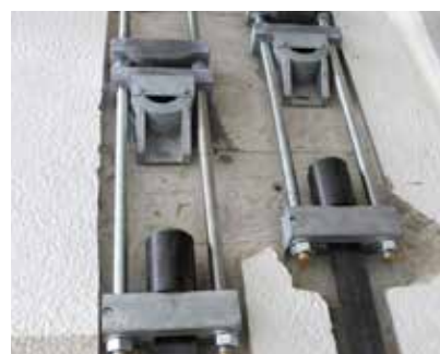
CONSOLIDARE PRIN SISTEM DE PRETENSIONARE
