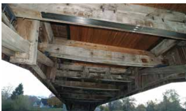
Grinda transversală consolidată cu CarboDur®
