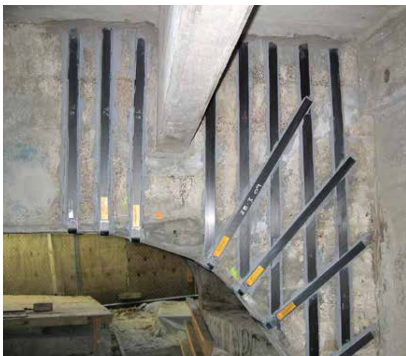
Benzi Sika CarboDur® și plăci CarboShear în formă de L lipite pe structura de beton.
