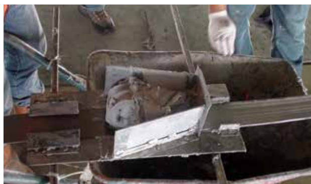
Acoperire plăci CarboDur® cu Sikadur®
