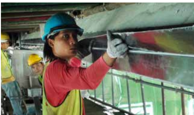
Instalare CarboDur®
