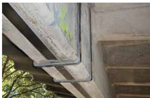
Benzi Sika CarboDur® și plăci CarboShear în formă de L lipite pe structura de beton.
