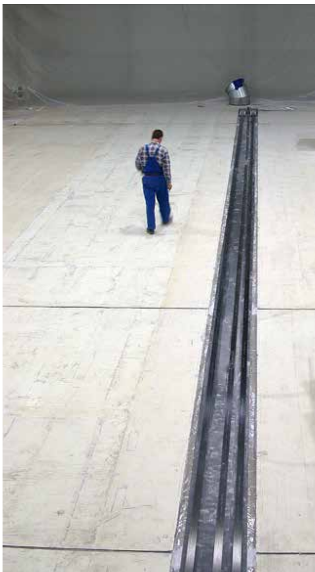
Cele mai lungi plăci CFRP post-tensionate instalate vreodată
