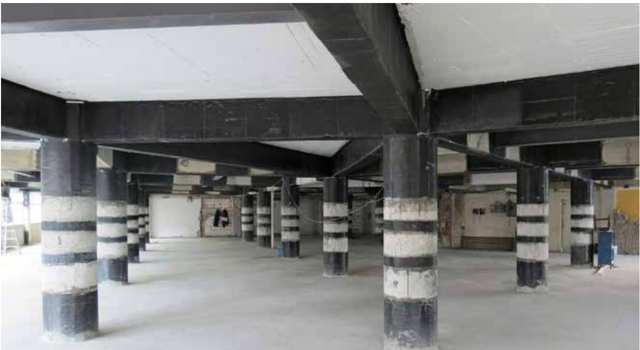
Grinzi și stâlpi consolidate(ți) cu SikaWrap®
