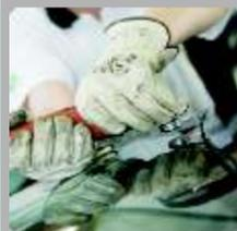
Indepartati geamul cu una din urmatoarele scule: cutit electric, coarda de pian, cutit incalzit electric (Avand temperatura reglata corect). Protejati-va ochii inainte de inceperea operatiunii.
