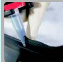
Aplicati un cordon triunghiular de adeziv pe marginea geamului sau a ramei metalice cu ajutorul duzei corect ajustata.
