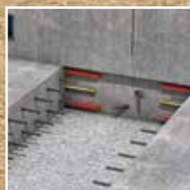
Rost de îmbinare între perete și planșeu
