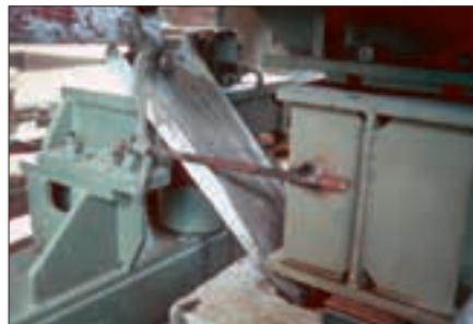
Subturnarea fundațiilor de mașini
