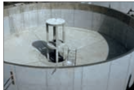
Rosturi în stații de epurare
