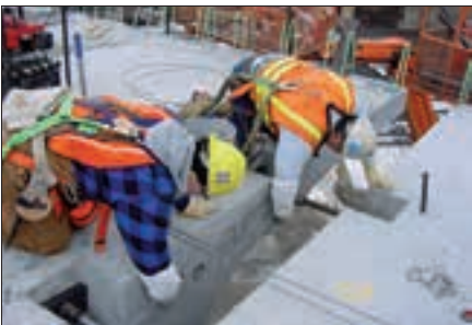
Ancorări și subturnări
