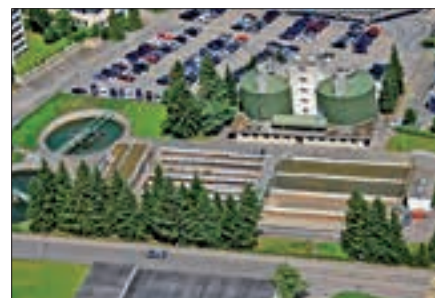
Stații de tratare a apei
