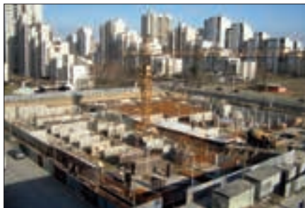
Producția de beton în șantier
