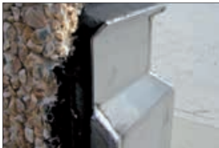
Rosturi de închidere la acoperișuri
