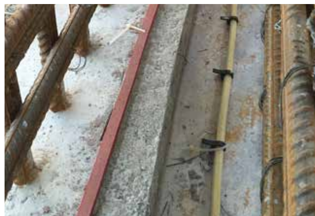
Sistemul SikaFuko® împreună cu profilul hidroflic expandabil în contact cu apa SikaSwell® A
