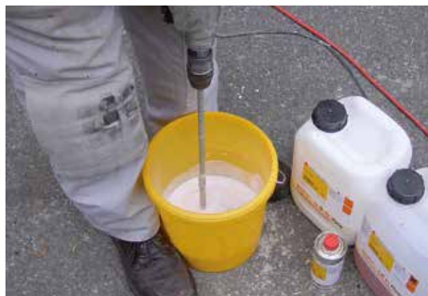
Amestecarea unei rășini de injectare Sika pe bază de acril
