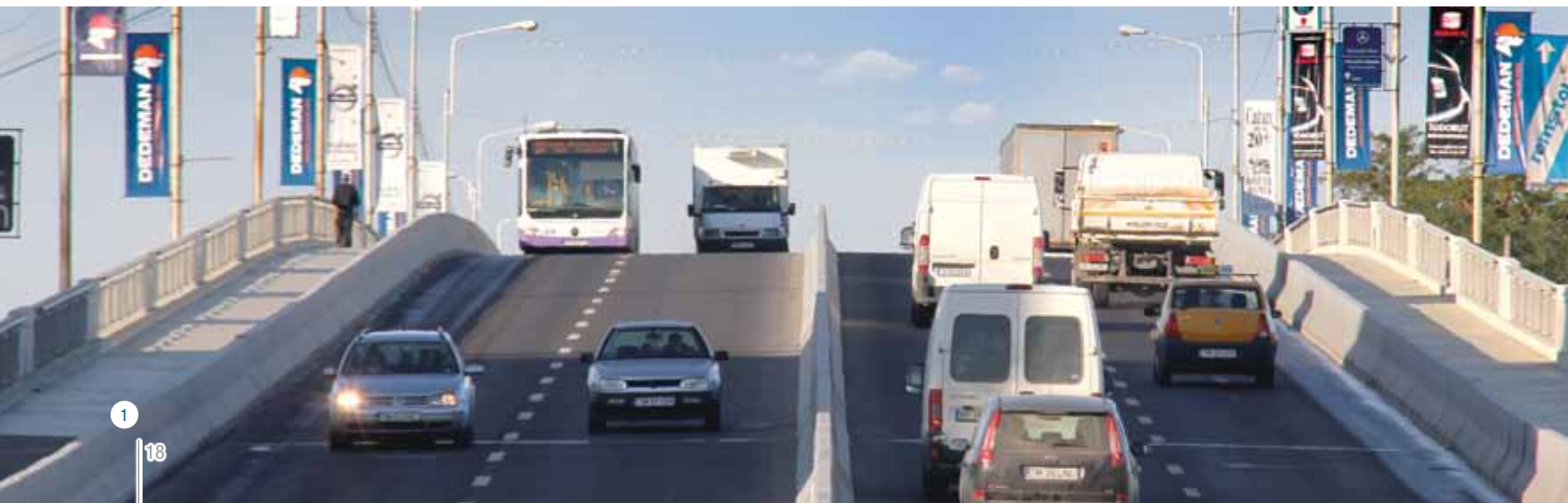
1. Pod Calea Șagului, Timișoara Bridge Calea Șagului, Timișoara
