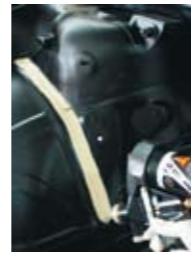
Pulverizare peste cordonul de sudură
